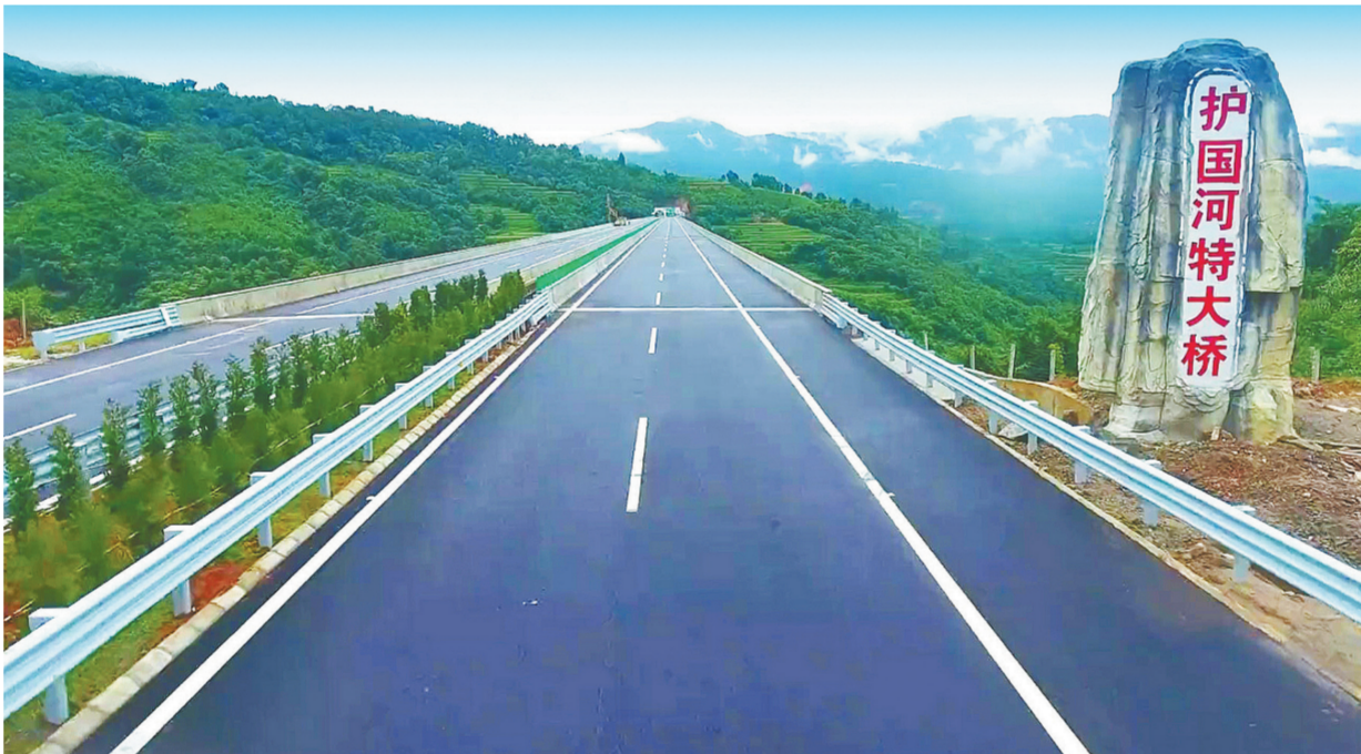
近日,由中铁十八局三公司参建的云南省腾冲至陇川高速公路正式开通运营。该公司承建的护国河特大桥是全线路控制性工程,全长1021.5米,最大墩高147米,为云南高速公路最高桥。他们创新采用高墩液压爬模施工工艺,大体积混凝土预埋冷却水管技术,成功攻克超高、超大桥梁墩柱混凝土浇筑施工难题。该高速公路全线建成通车后,对助力少数民族聚居地区脱贫致富具有重要意义。图为已经通车的护国河特大桥。
