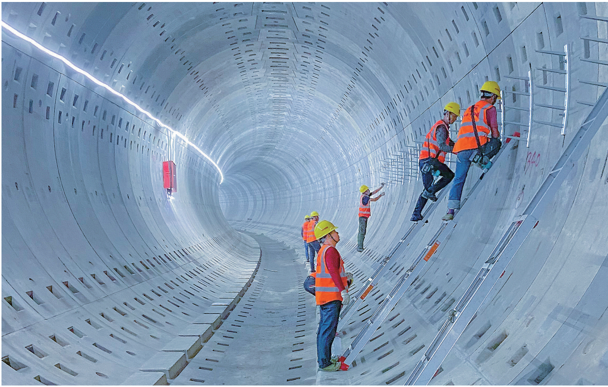
8月20日,由中铁十四局电气化公司承建的上海地铁15号线通信系统正式进入联调联试阶段。该线路全长42.3公里,共设30座车站。建成通车运营后,将成为国内首条一次性开通最高等级全自动驾驶运营里程最长的大运量轨道交通线路。图为现场工人正在进行电缆支架安装。 钟文星 摄
