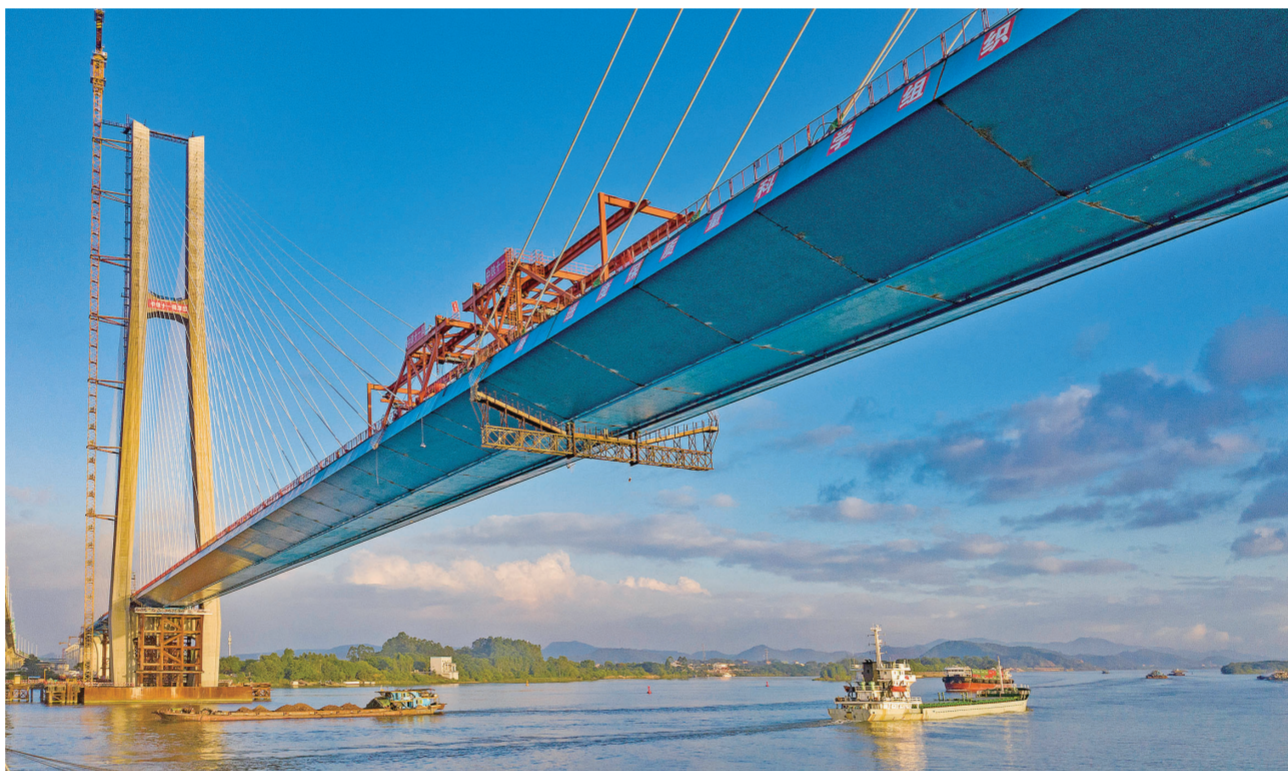
8月12日,由中铁十一局承建南沙港铁路跨西江斜拉桥顺利合龙。该桥全长1117.5米,主跨跨径600米,设两座H型桥塔,塔高分别为208米和200米,共有96对斜拉索,是双线货运铁路建设史上跨度最大的斜拉桥。南沙港铁路全长约88公里,为双线货运铁路,建成通车后南沙港集装箱班列将直达欧洲。 金 伟 摄
