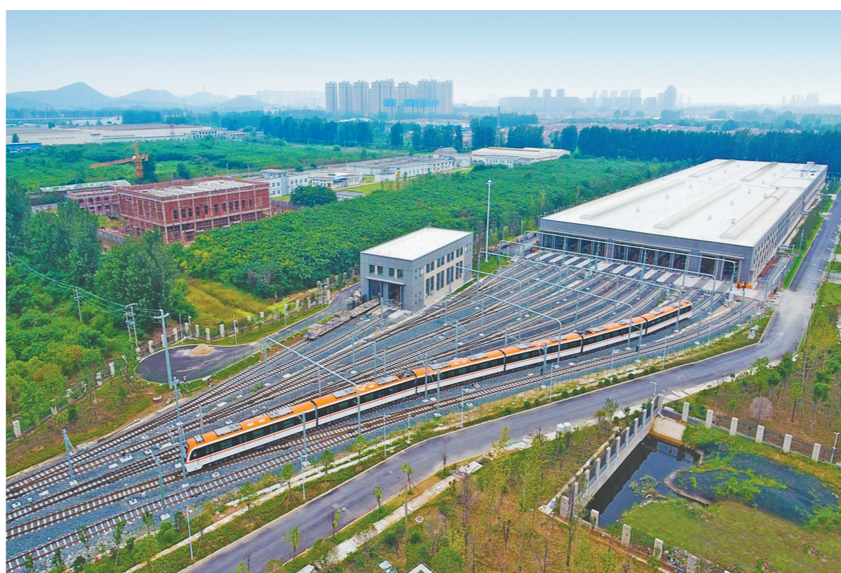
8月5日,由中国铁建承建的徐州地铁2号线项目通过验收。该线路全长24.15公里,开通后将大大提升徐州交通的流动性、城市辐射力和新老城区的经济发展活力。图为地铁列车驶入徐州地铁2号线停车场。 钟咏峰 摄
