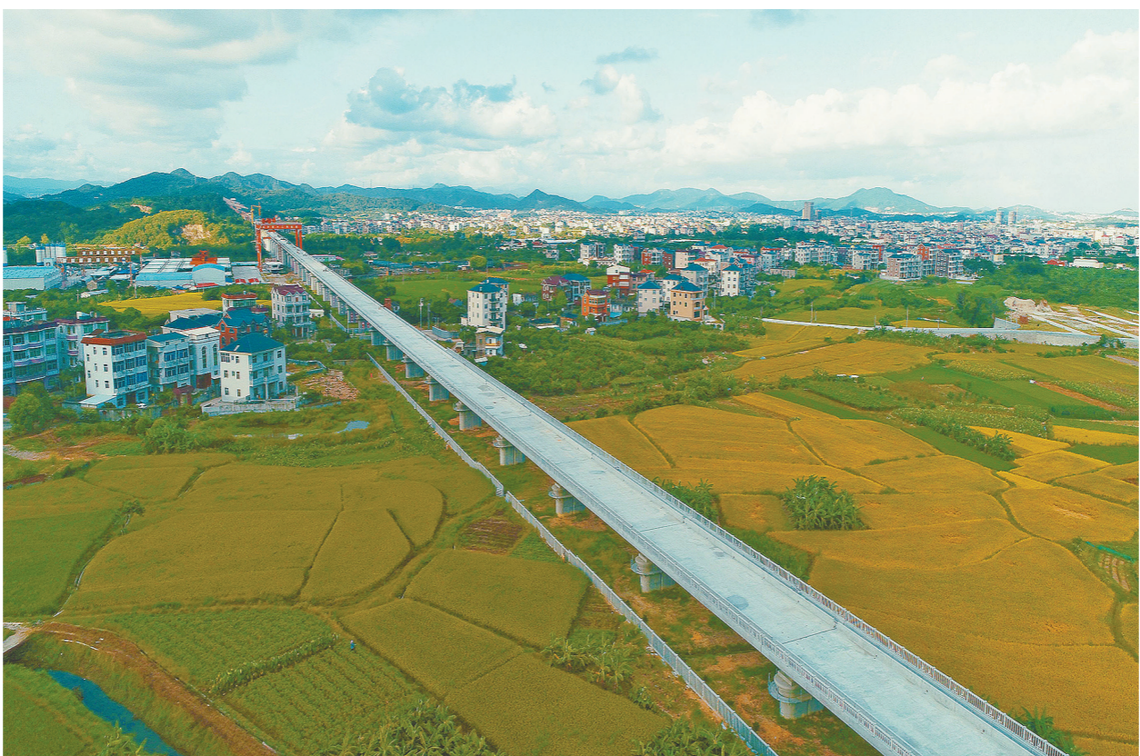
8月4日,由中铁十二局承建的福厦高铁渔溪特大桥跨沈海高速公路连续梁合龙。该桥全长约2公里,在建设中大范围应用装配式围挡,建立标准化绿化保护体系,是全线工程结构和绿色文明样板区段,成为全线绿色文明施工的典范。丁明明 摄
