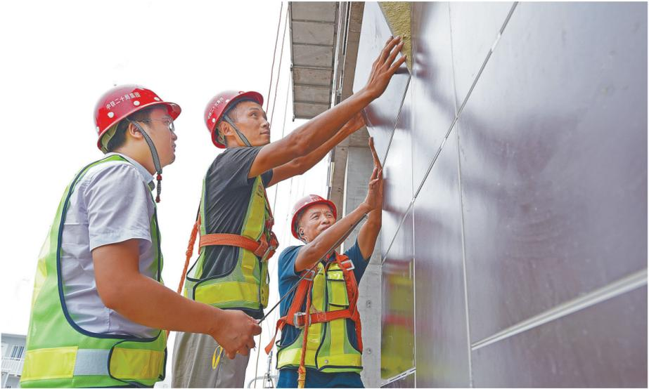
由中铁二十局六公司承建的西安西咸新区泾河新城第二学校,是西安市重点民生工程,建成后解决2700多名学生的入学问题。为确保工程内外美,给学生们提供更好的学习环境,该项目部在施工工艺和材料选用上不断创新。图为日前施工人员在小学部教学楼外墙安装薄型陶保温装饰复合板,既增强了保温性能,又达到了美观效果。 袁庆摄
