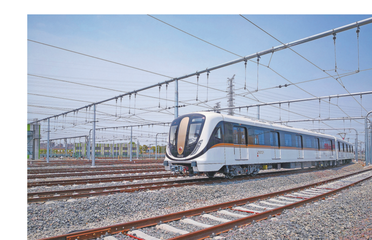
7月30日,由中铁十一局电务公司等单位参建的上海轨道交通15号线进入全线动车调试阶段。全线通车运营后,将成为国内首条开通具备最高等级全自动驾驶大容量轨道交通线路。图为动车在轨道上进行调试。 刘杰摄
