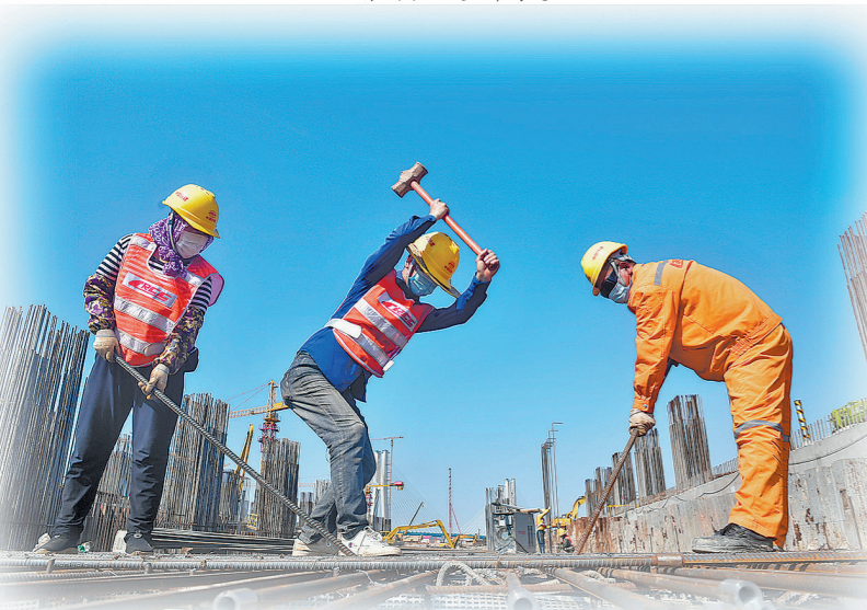
地铁车辆段工人承台作业。
