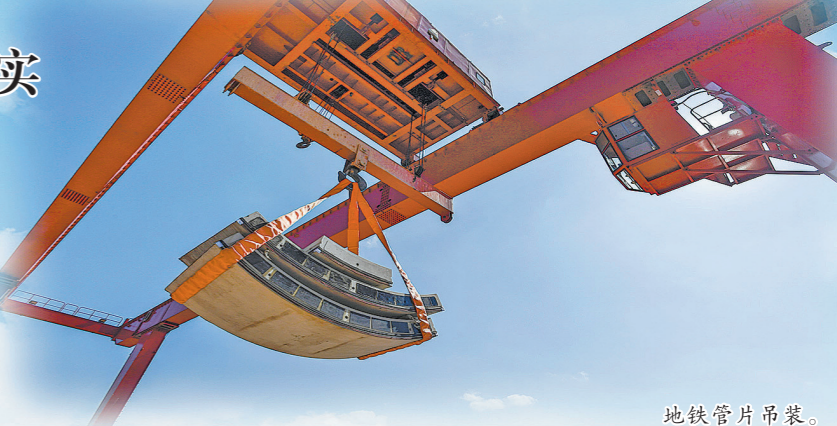
地铁管片吊装。
