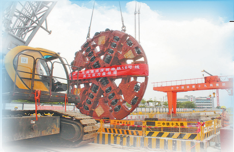
盾构机刀盘吊装。
