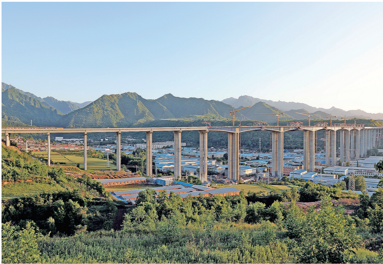
日前,由中铁十一局一公司承建的宝坪公路清水河特大桥全桥贯通。该桥全长1440米,为陕西省首座新型结构桥梁。主桥上部结构为波形钢板预应力混凝土连续刚构,解决了传统混凝土箱梁腹板易开裂等问题,具有技术先进、经济性好、造型优美等显著特点。图为贯通后的清水河特大桥。
