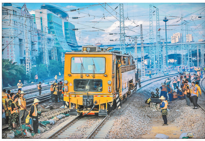
大型养路机械助力昆明局四线大拨接(二等奖)
