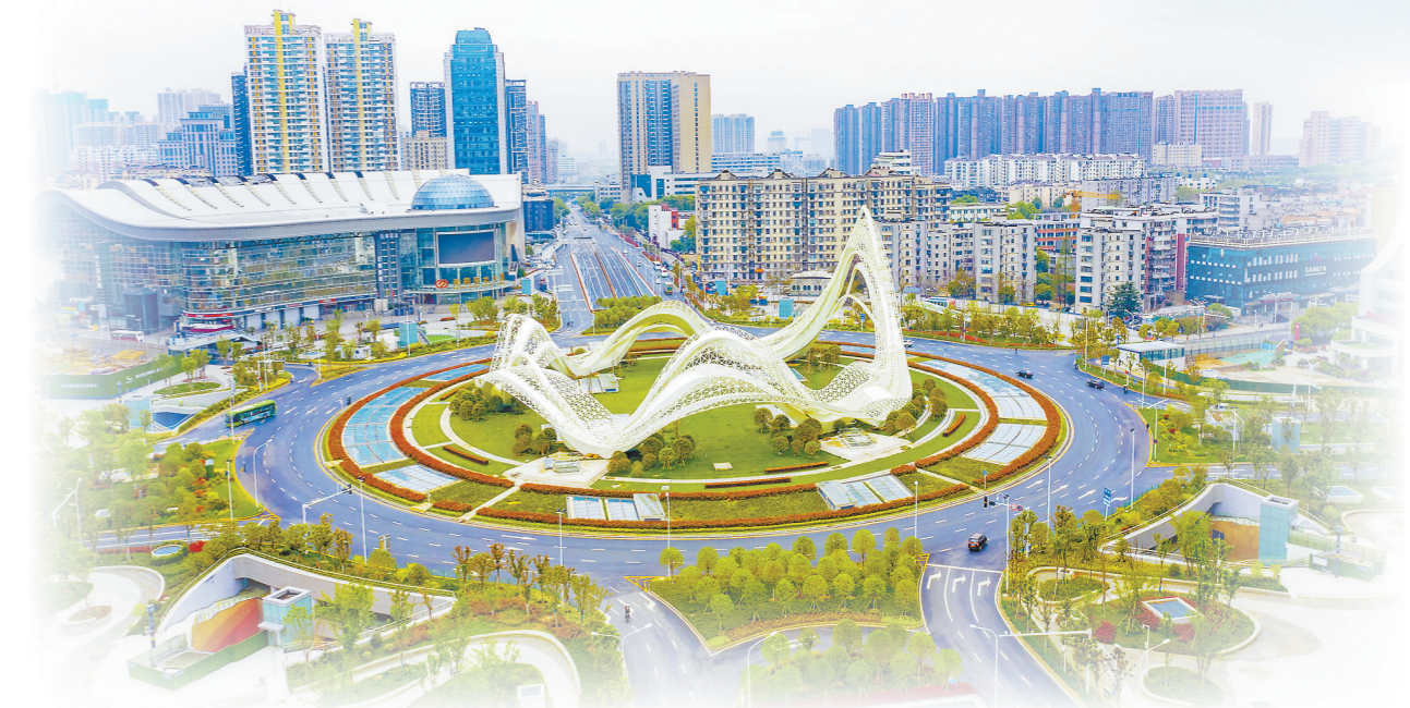
铁四院设计、中铁十一局承建,并获得多项专利的亚洲规模最大城市地下综合体——武汉光谷广场综合体。 金伟摄
