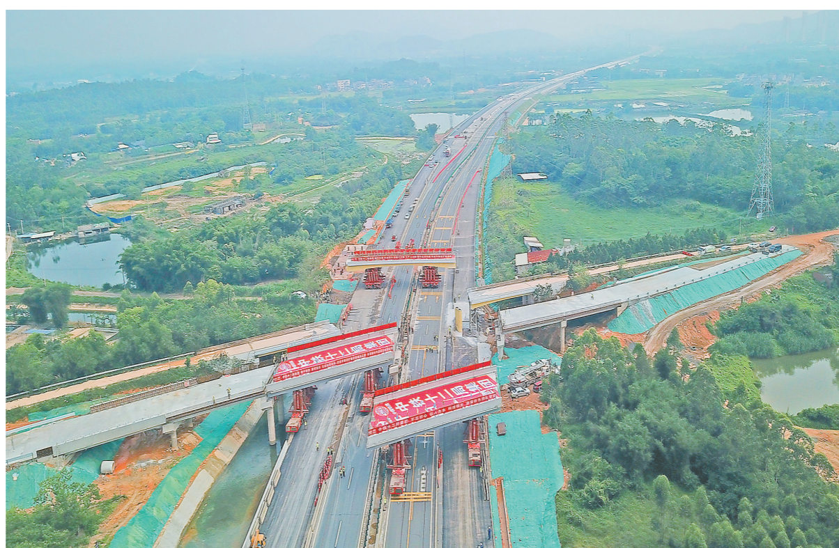
中铁十二局承建的开阳高速公路扩容改造2标段2号桥,重达570吨,是全线唯一一座曲线斜角桥,也是广东省高速公路改扩建工程最大的桥,架设斜角天桥工程。日前,他们采用“千吨级桥梁上部结构拼装多功能智能一体机”,在同一时间段内完成了旧桥拆移、新桥架设任务,这在广东省公路建设中尚属首次。图为拆移、架梁现场。 武羽摄
