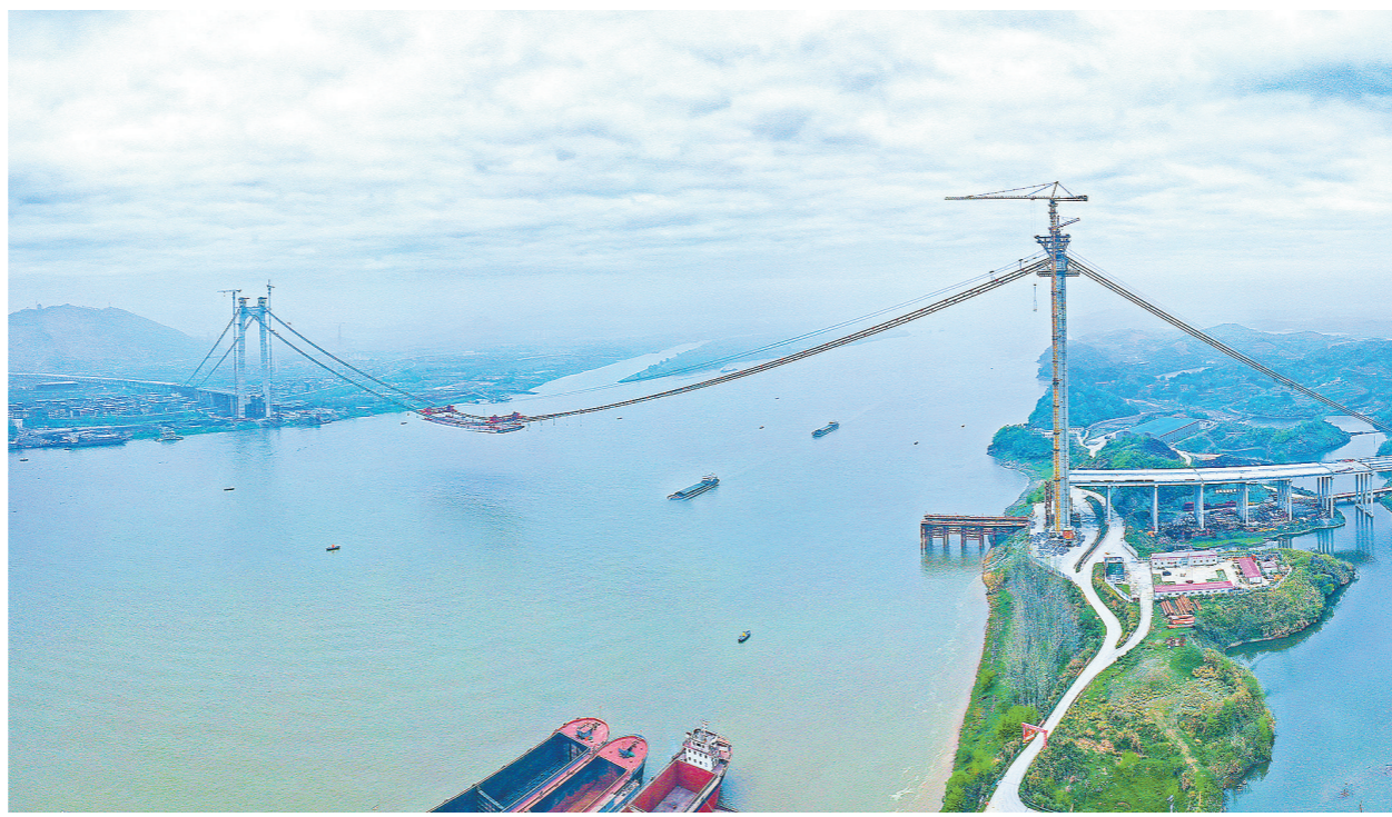
随着疫情防控形势好转,中国铁建大桥局承建的湖北棋盘洲长江公路大桥全面恢复施工。该桥主跨1038米,是湖北省规划的“七纵五横三环”高速公路网中武汉市环线高速公路的重要组成部分。日前,建设者成功完成该桥复工后首片钢箱梁吊装提升,预计今年6月底可实现主桥合龙。 田野 摄
