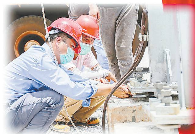
新冠肺炎疫情期间,项目坚持一手抓疫情防控,一手抓施工生产。
