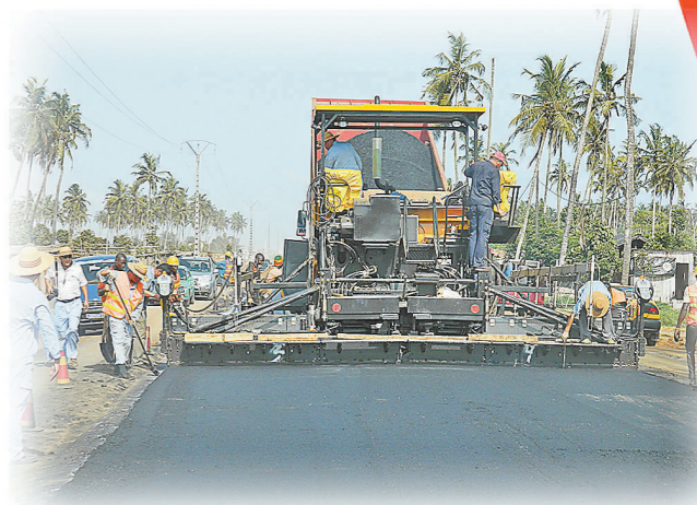
正在进行高速公路工程沥青摊铺施工
