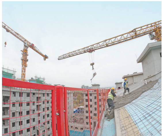
图为工人们在房顶进行施工作业。 孔祥文 摄
