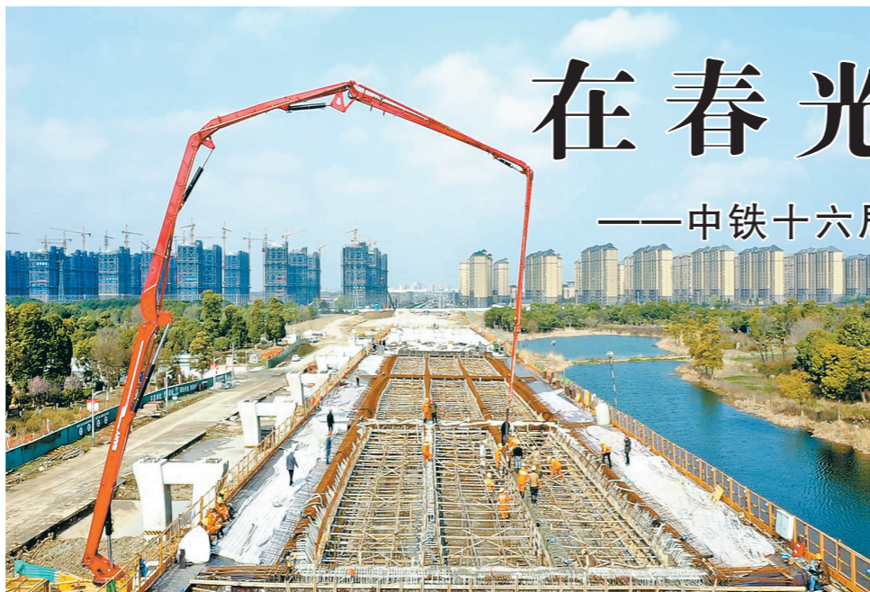
图为中铁十六局三公司苏州滑湖大道主线高架桥现浇梁施工现场。 范超辉 摄
