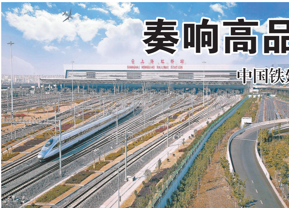
图为中国铁建参建的上海虹桥交通枢纽工程。 庞曙光 供图
