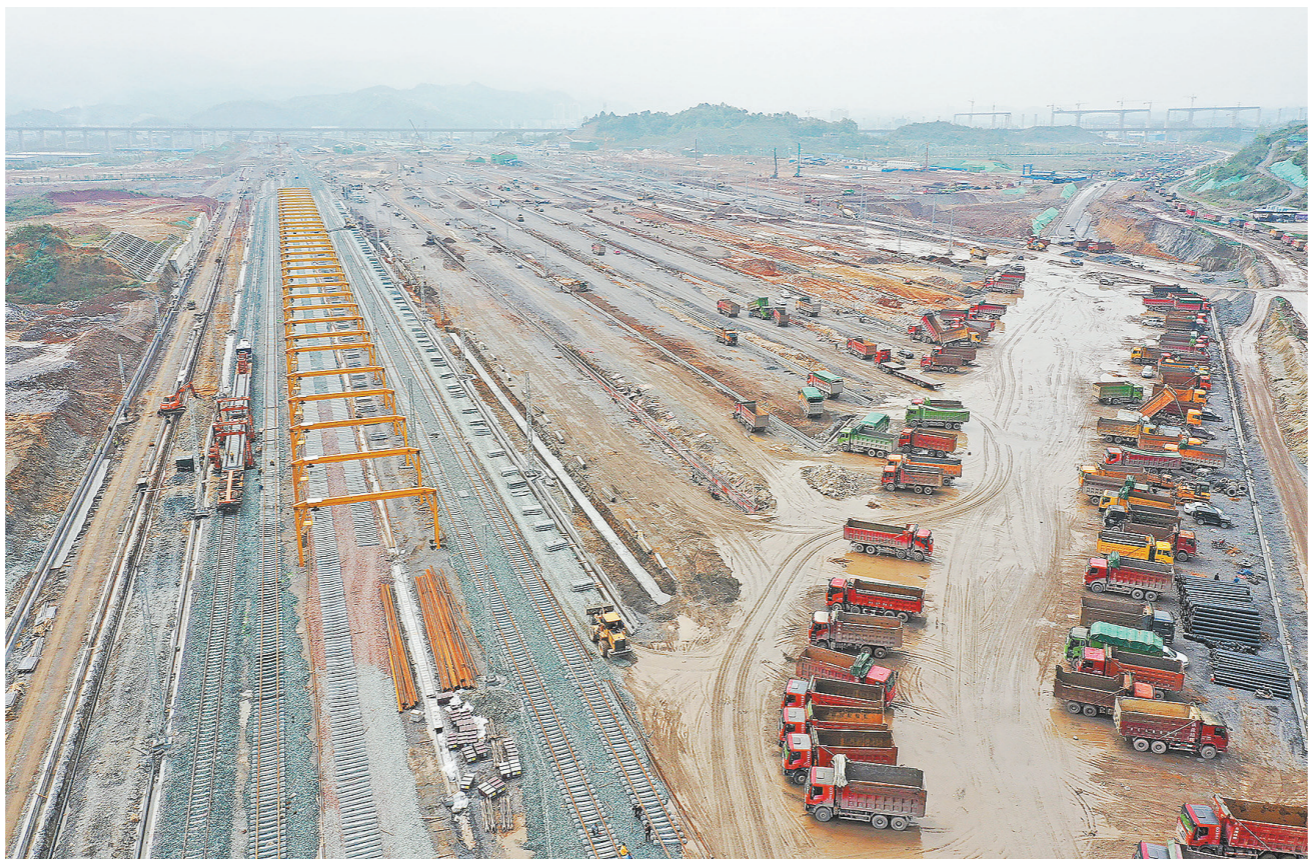
中铁二十局渝昆铁路增建二线7标段(怀化西编组站)项目是连接沪昆、焦柳、渝怀等6大铁路干线的中枢编组站。自2月份全面复工以来,中铁二十局组织1600多名施工人员、500多台施工机械全力推进项目建设,目前已开始铺轨。图为渝昆铁路增建二线7标段施工现场。 程凯摄
