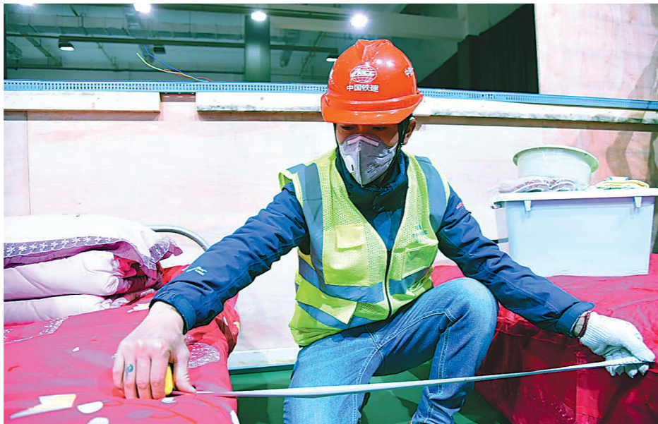
图为2月10日,田洋哲在“方舱医院”建设现场安装床位。 陈 磊 摄
