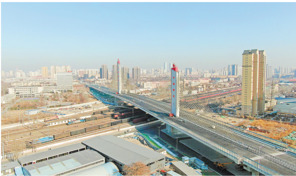
日前,由中铁十八局五公司参建的世界上同类型跨度最大、转体吨位最重、球面平较直径最大的斜拉桥——河北省保定市乐凯大街斜拉桥正式通车,助力京津冀交通一体化建设。该桥采用于母塔双转体技术,母塔转体桥梁长263.6米,重4.6万吨。
