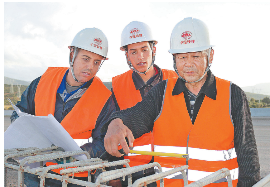
图为罗万全(右一)指导“洋徒弟”进行钢筋绑扎。 潘碧霞 摄
