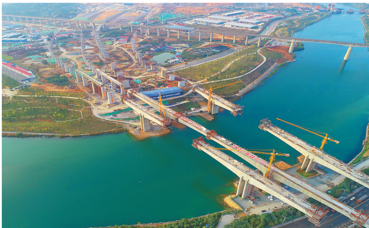
近日,由中铁二十五局承建的渝怀铁路增建二线全线控制性工程——舞水湾特大桥3号桥顺利合龙。该桥所属的3座桥为跨度168米的连续刚构桥,需在相距不足100米的范围内同时施工,并排跨越连续转弯超过180度的急弯河道和多处市政道路,属国内首次。图为舞水湾特大桥3号桥完成合龙。张 晶 摄
