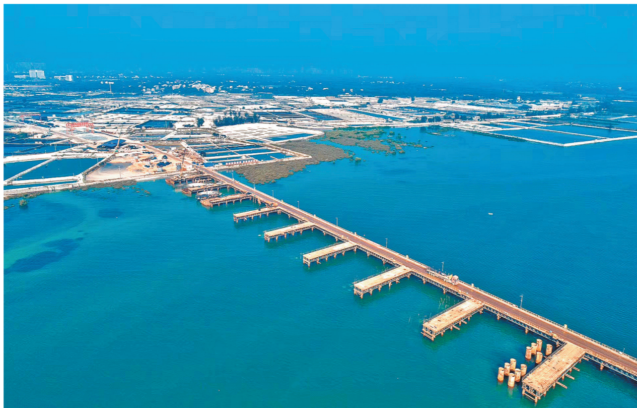
在广西北海市跨海第一桥西村跨海大桥施工中,中铁二十局三公司秉持绿色施工理念,采用反循环钻机将沉渣和泥浆分离,并及时将施工垃圾分类收集后运走,减少桩基施工对海洋环境的污染。图为正在运输垃圾的车辆驶过西村跨海大桥。 陈福得 摄
