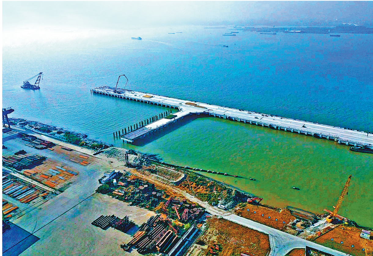
10月30日,由中国铁建港航局二公司承建的PPP内河码头工程——泰兴港区七圩公用码头顺利完成面层浇筑。该码头建成后,将充分发挥中国铁建品牌优势,整合长三角特别是锡常泰货物资源,实现江海大联运,对推动当地经济跨越式发展具有重要意义。 姜东序 摄
