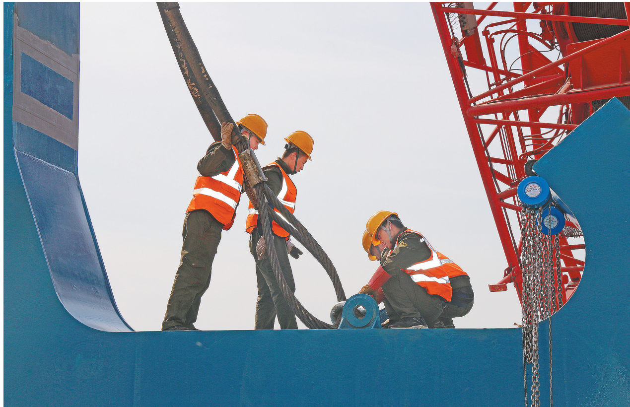
10月28日,由中国铁建大桥局西北公司承建的世界跨度最大的引江济淮工程淮河总干渠钢渡槽安装工程正式启动。淮河总干渠钢渡槽全长246米,主跨110米。引江济淮工程沟通长江、淮河两大水系,是中国跨流域、跨省重大战略性水资源配置和综合利用工程,被誉为安徽省基础设施建设的“一号工程”。图为技术人员正在连接首节钢桁梁,为架梁做准备。 苗华华 摄
