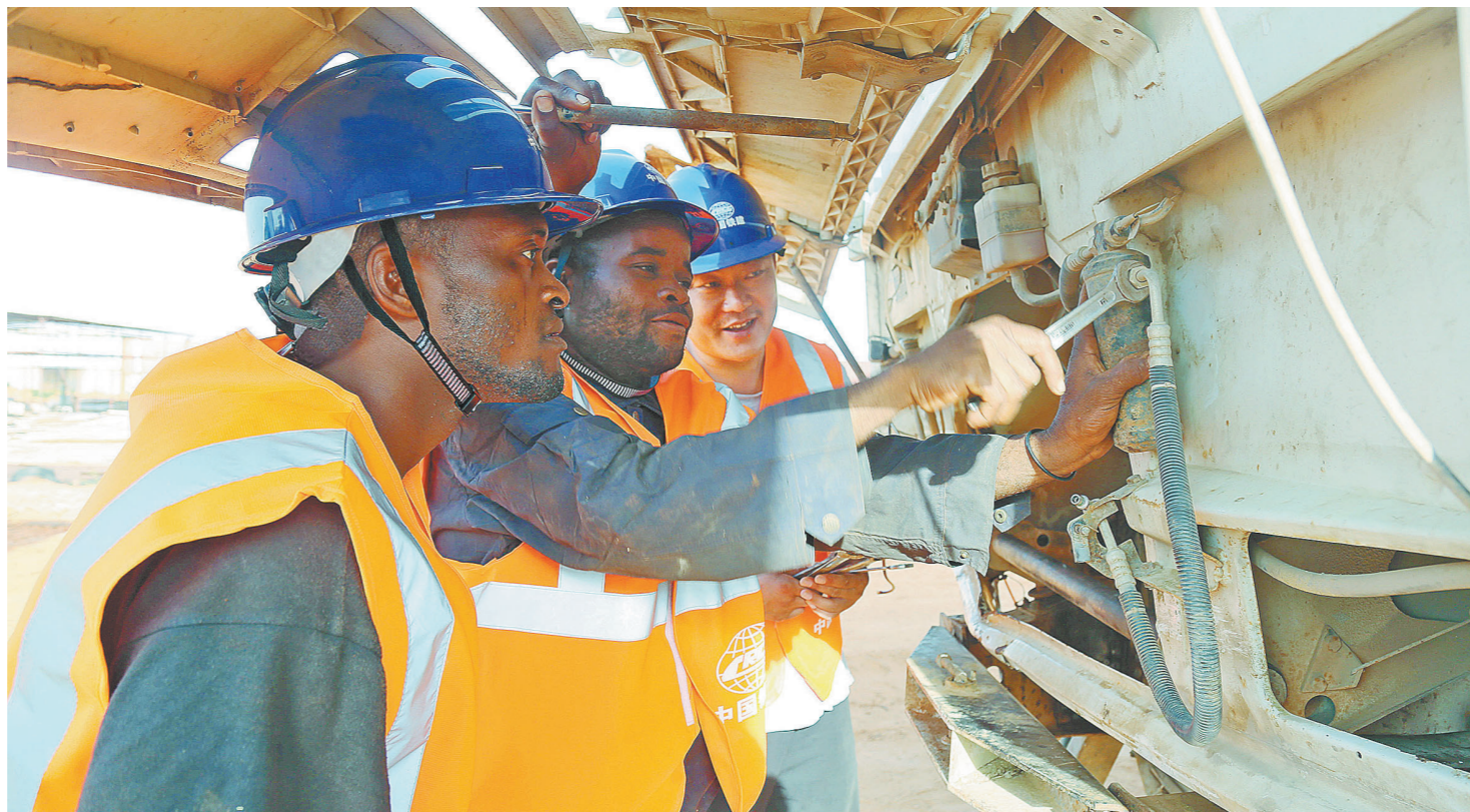
在安哥拉二期大市政项目建设中,为确保工程如期履约,中铁十四局通过开展技术革新、提高机械设备能效、大量聘用属地工人等措施,既加快了工程进度,又节约了施工成本,为解决当地就业、加快经济发展作出了积极贡献,赢得了当地居民和政府的好评。图为当地时间10月28日,安籍员工在中方技术人员指导下检修施工车辆。
