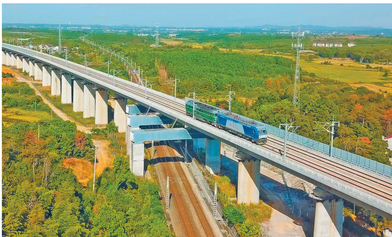
10月20日,由中铁十一局四公司参建的江西南昌至赣州高铁正式进入联调联试阶段,预计今年年底通车,井冈山革命老区、赣南等原中央苏区将迈入高铁时代,江西将实现市市通动车。昌赣高铁全长约416公里,设计时速350公里,是京港高铁的重要组成部分。图为联调联试车辆在昌赣高铁游荡大桥上行驶。肖帆摄
