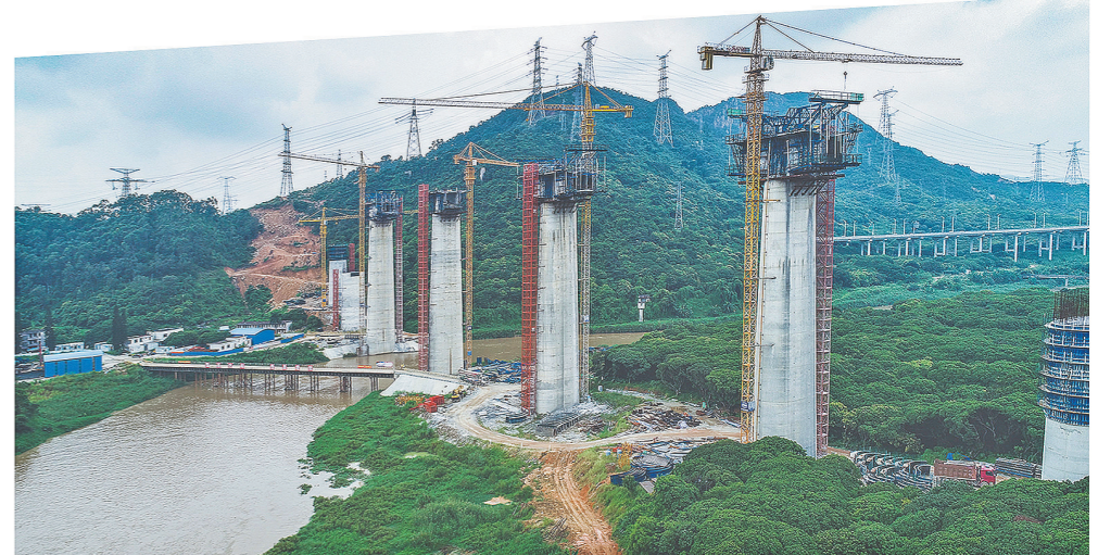
赣深铁路石马河特大桥
