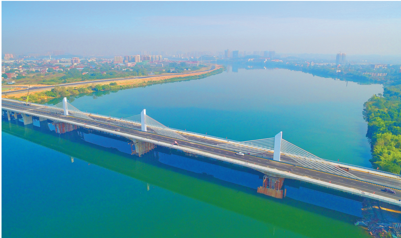
近日,由中铁十七局五公司承建的湖南省永州市首座大型斜拉桥九嶷大桥正式通车,有效缓解中心城区的交通压力,加快产业升级具有重要意义。九嶷大桥全长1183.56米,在国内首次使用改进型长螺旋钻孔扩孔技术。图为通车后的九嶷大桥。欧阳车 摄
