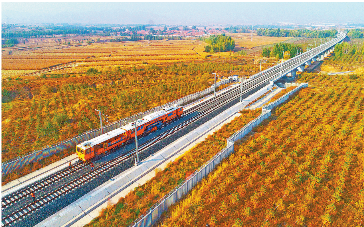
10月12日上午,由中铁二十局承建的北京2022年冬奥会重点配套交通基建工程——崇礼铁路全线轨道精调精调工程完工,为全线联调联试奠定了坚实基础。崇礼铁路是国内首条在大风沙严寒天气下设计时速250公里有砟轨道客运专线,建成后将与京张高铁正线形成北京至张家口崇礼冬奥赛区最便捷客运通道,届时从北京乘高铁到张家口崇礼赛区看冬奥盛会仅需1小时。 曲忠志 摄
