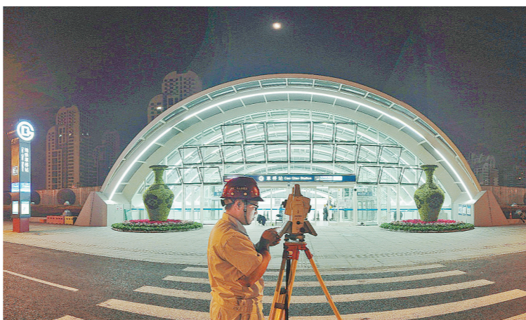
凌晨两点,一名年轻的测量员在站前测绘。在有效工期不足600天的施工中,建设者们受到各方支持,克服各种困难,最终如期交付验收。
