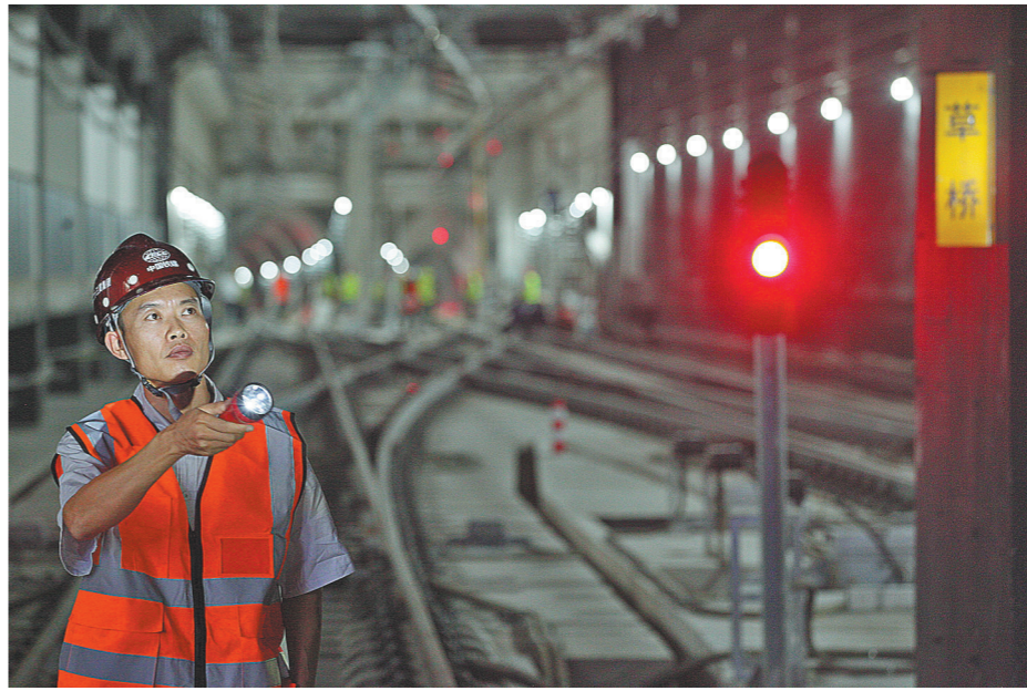
大兴机场线开通前夕,员工最后一次在站内轨道区间进行安全巡视。在草桥一站三区间全长1240米的标段内,遭遇了79个风险源,其中“5个特级风险源”、26个“一级风险源”。遭遇10次下穿,两线4轨3次上穿既有地铁10号线,距离最近处仅37.7厘米。
