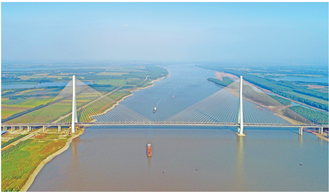
日前,经过近4年努力,由中国铁建大桥局一公司参建的世界第七大斜拉桥——湖北石首长江公路大桥建成通车。该桥主跨820米,是江汉平原和洞庭湖平原腹地的一条南北向快速通道,对于改善长江两岸8个县市区的交通状况,带动石首、陵陵等城市及长江两岸经济社会发展等具有十分重要的意义。 谷绍元 摄
