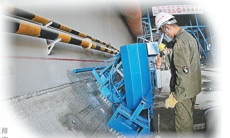
自主研发的水沟电缆槽边墙一体式凿毛机正在工作
