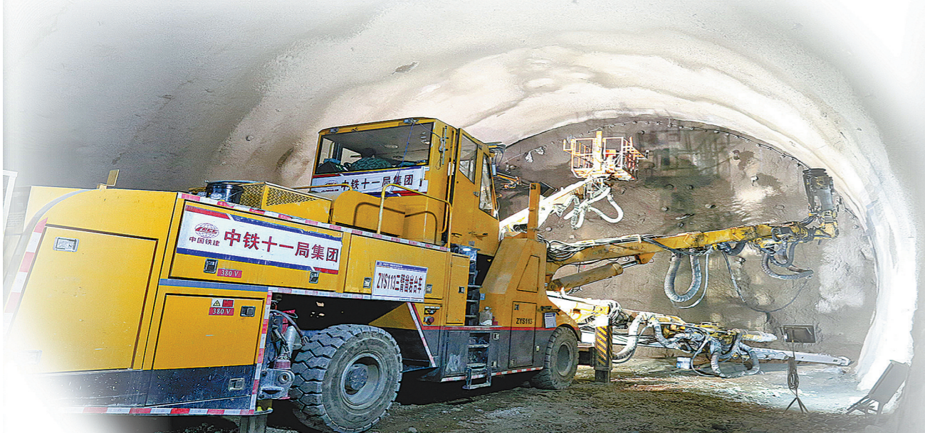
全电脑三臂凿岩台车钻孔作业场景
