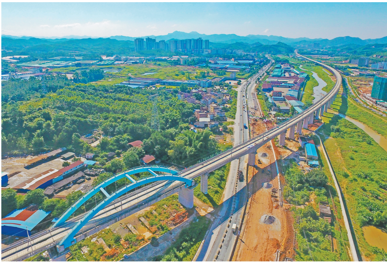
日前,由中铁十一局参建的广州(清)清远城际铁路完成正线铺轨,为下一步联调联试奠定了基础。该工程通车后将有力推动清远南部融入广州半小时经济圈。图为建设中的广清城际铁路。 齐晓阳 摄
