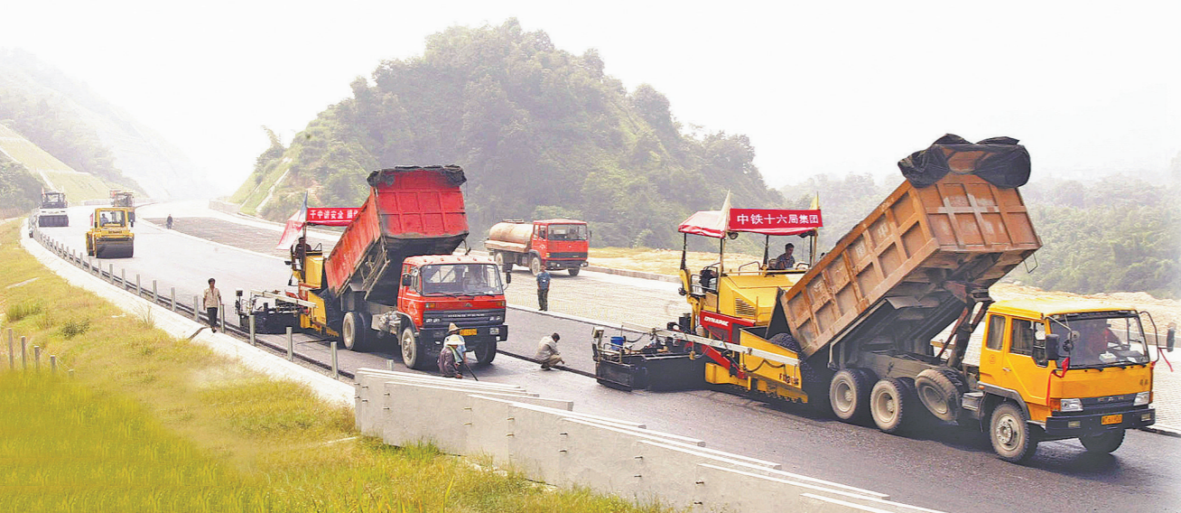
路面施工现场
