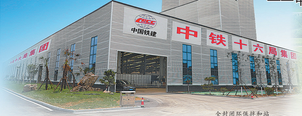
全封闭环保拌和站
