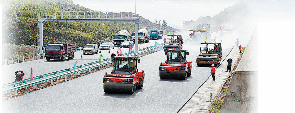
路面施工现场
