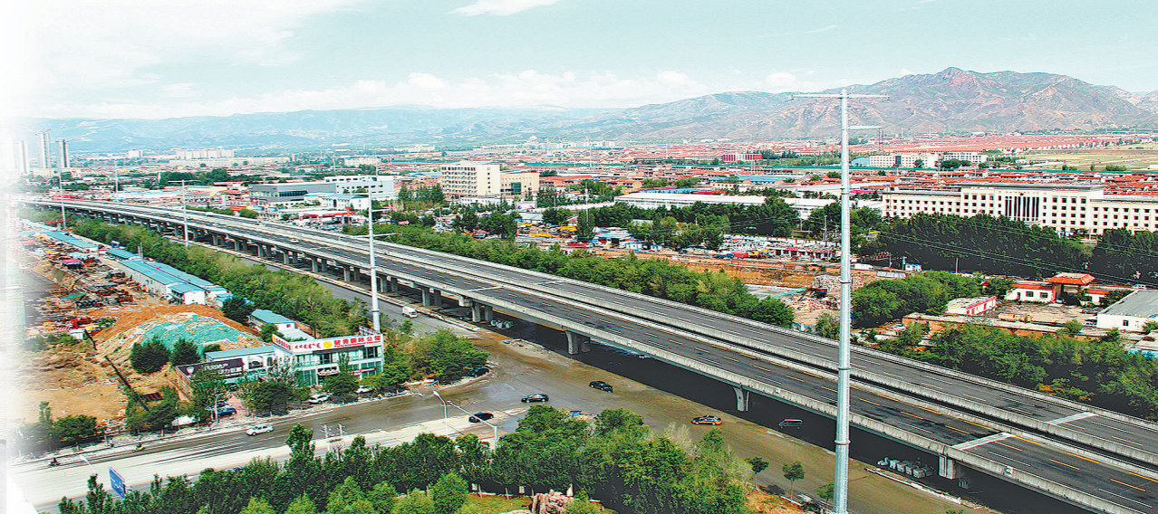
中铁十六局承建内蒙古呼和浩特西北二环快速路路面工程
