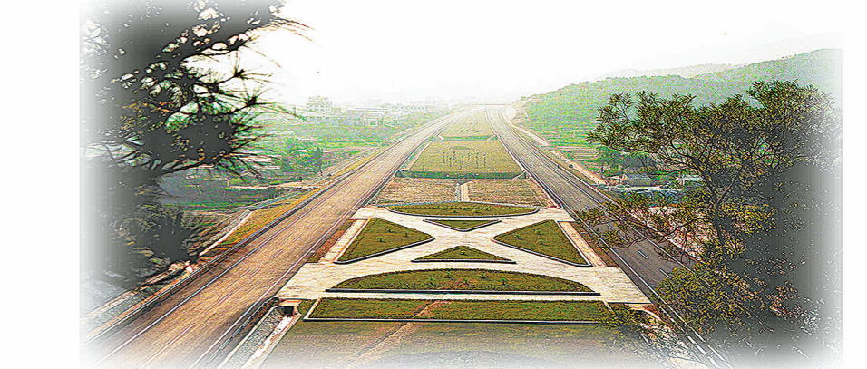
中铁十六局承建福建省泉厦高速公路
