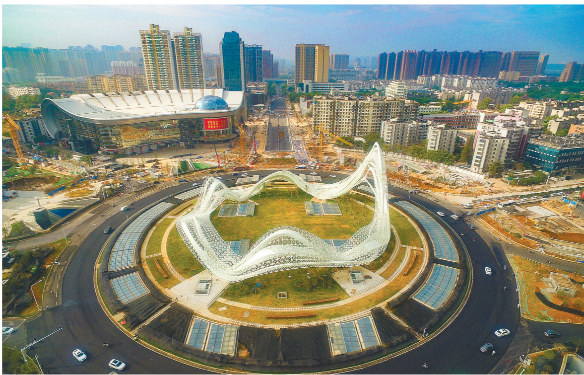
8月20日,由铁四院总体设计、中铁十一局一公司承建的武汉光谷广场综合体1号下沉庭院主体结构顶板顺利封顶,标志着武汉光谷广场综合体主体结构施工任务全部完成,为地面工程在军运会之前完工奠定了坚实基础。该综合体是亚洲最大城市综合体项目,总建筑面积约16万平方米。图为武汉光谷广场综合体。 陈明 摄
