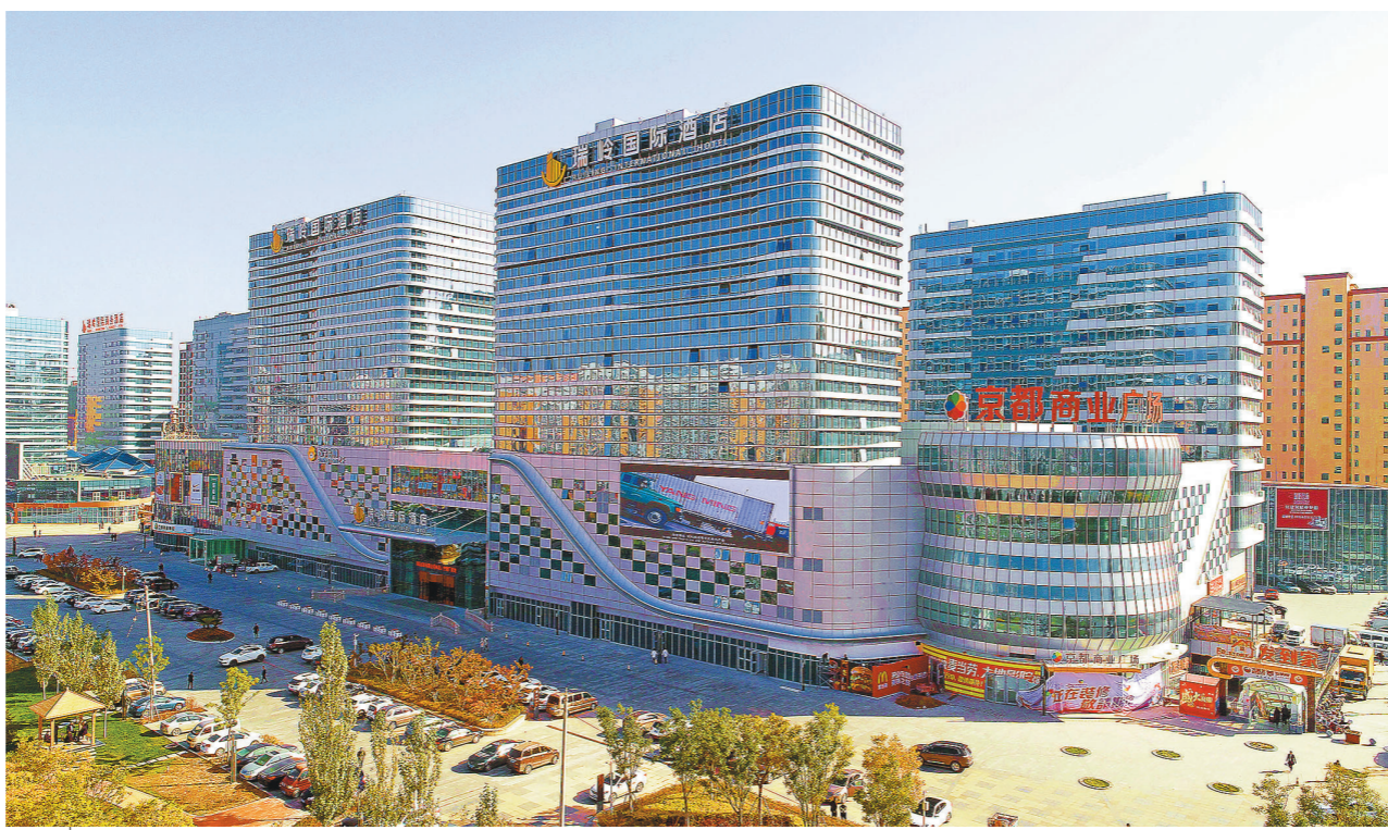
日前,由中铁二十局市政公司承建的兰州新区核心区最大商业综合体——瑞岭国际商业广场项目全部通过竣工验收。瑞岭国际商业广场总规模23.2万平方米,集购物、美食、休闲、办公、文化等功能于一体,为兰州新区市民创造了一个全新的一站式消费娱乐平台。图为瑞岭国际商业广场外景。 闫彦龙 摄
