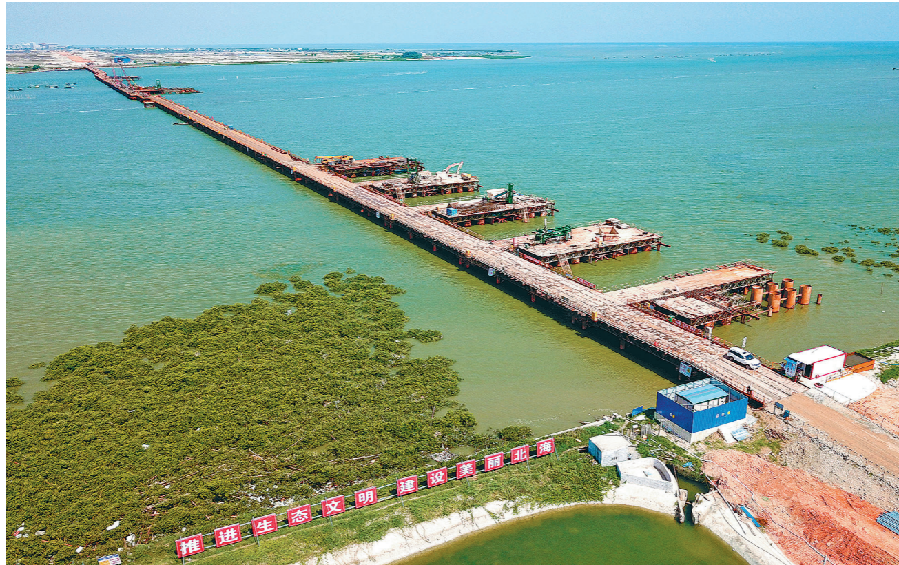
8月15日,由中铁二十局三公司承建的北海市跨海第一桥——西村港跨海大桥主桥顺利合龙。西村港跨海大桥全长2544米,设计为双向6车道。该桥的建设,将连通北海市银滩新城和海洋新城,对北海市建设国家海洋经济创新发展示范城市具有重要意义。图为合龙后的西村港跨海大桥主桥。
