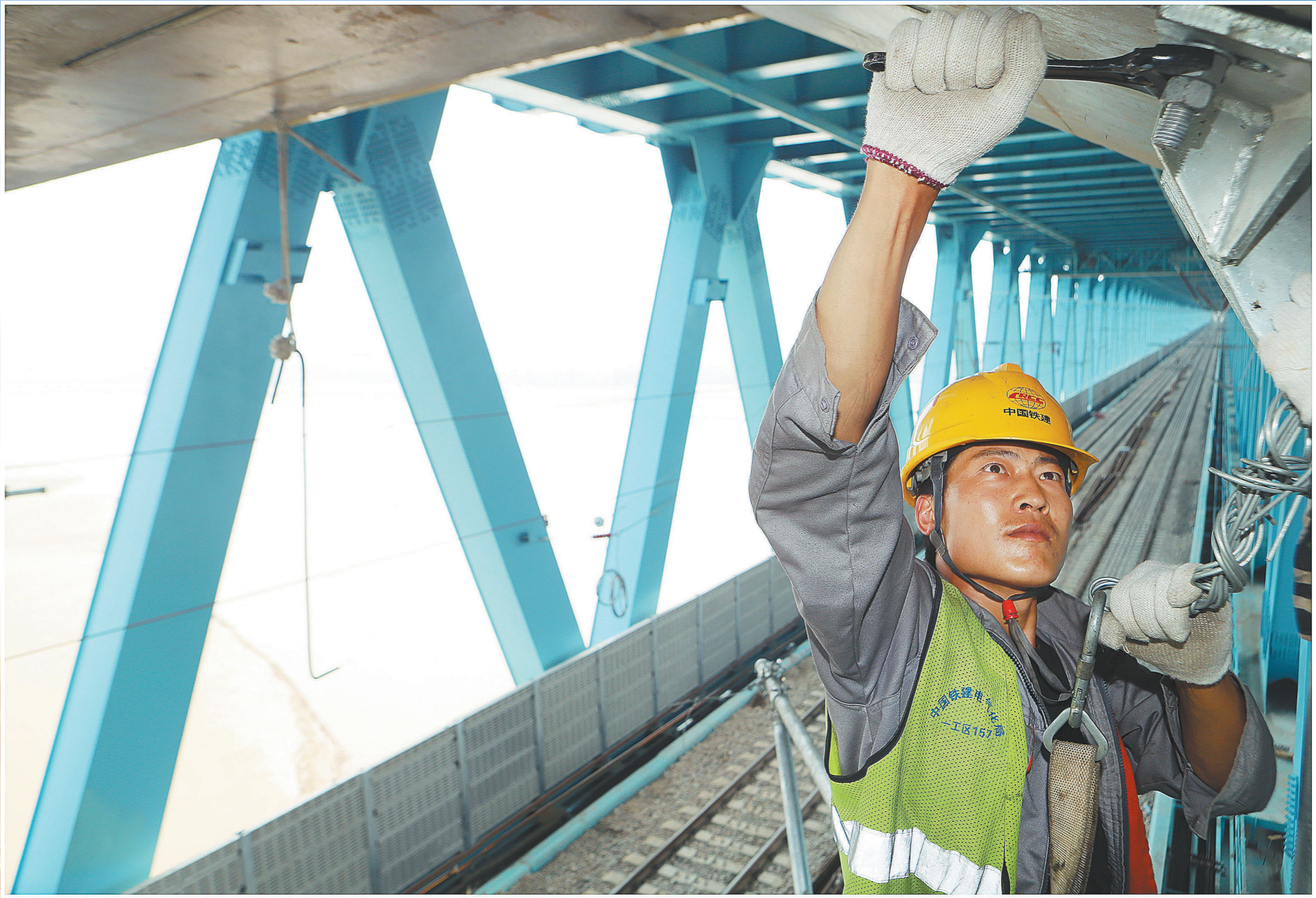
工人在三门峡黄河公铁两用大桥上进行接触网吊柱安装
