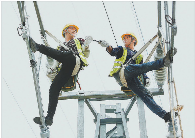
两位相互协作施工的接触网工友
