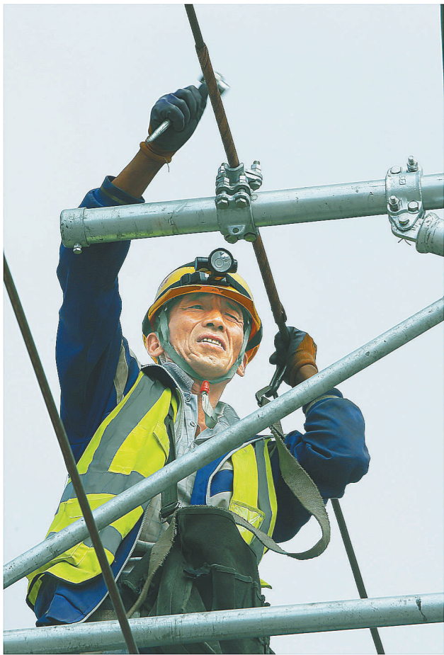
紧固接触网承力索座的工人
