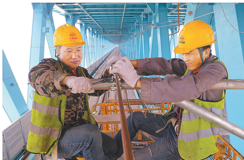
三门峡黄河公铁两用大桥上专注于平推克缺作业的接触网工人
