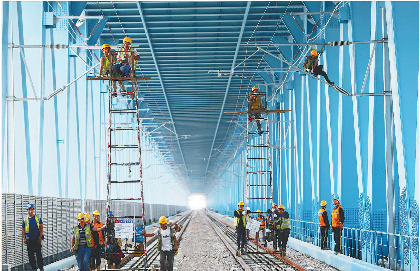
蒙华铁路三门峡黄河公铁两用大桥接触网施工
