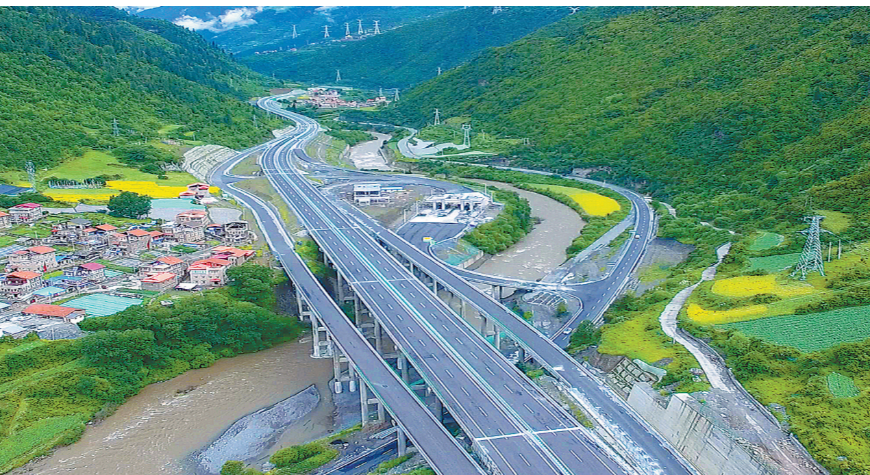
8月13日,由中铁十七局四公司参建的汶马高速公路进入试运营阶段。施工中,该项目克服山体滑坡、施工作业面狭窄、频跨国道施工等难题,按期完成工程建设。据悉,汶马高速公路全长172公里,是四川省第二条进藏高速公路,也是内地深入阿坝州藏区经济走廊和战略走廊,对促进沿线经济发展具有重要意义。图为汶马高速公路色尔米特大桥。张鹏摄
