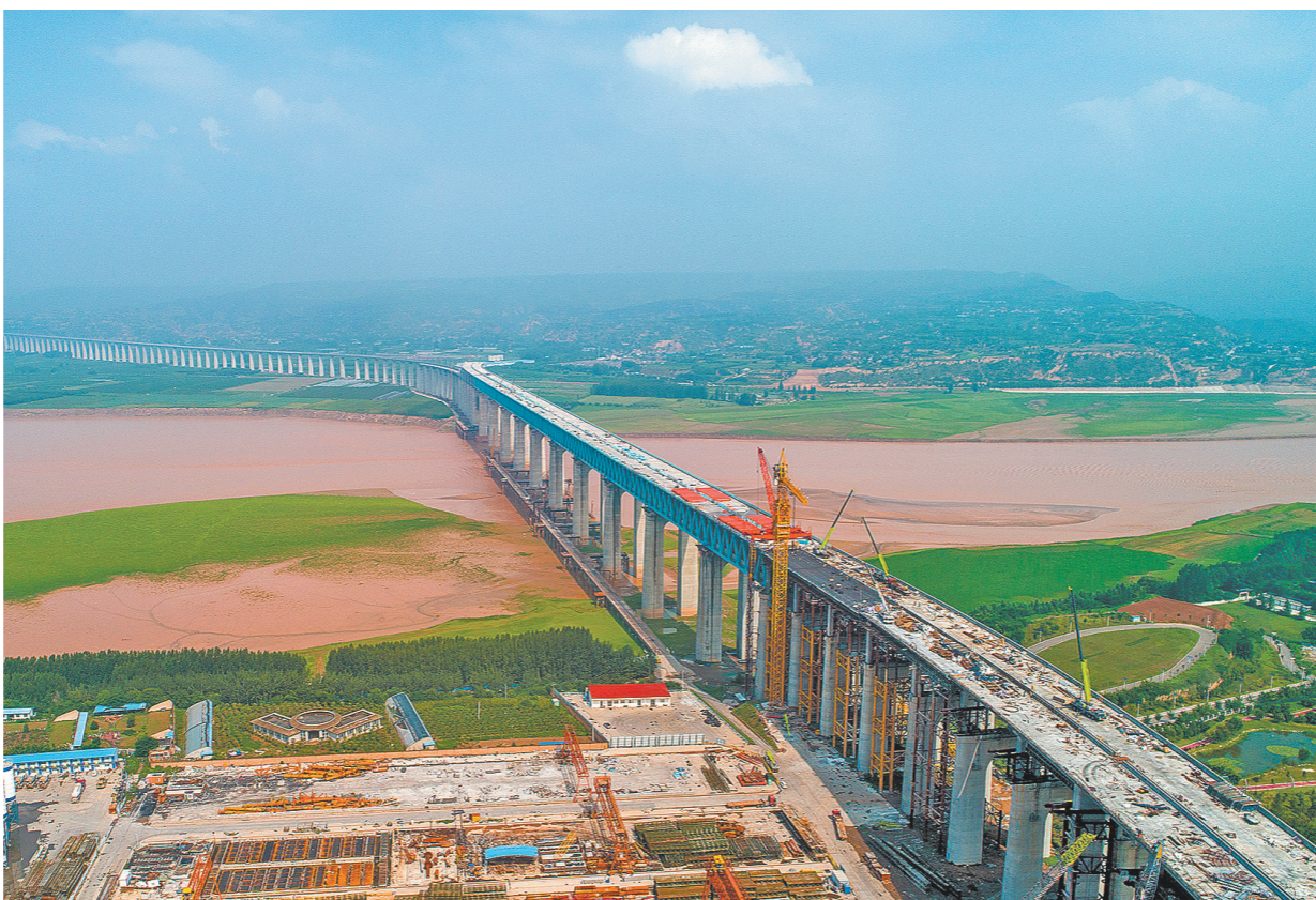
8月9日,由中国铁建大桥局四公司施工的蒙华铁路三门峡黄河公铁两用大桥南引桥公路连续梁右幅浇筑完成,标志着大桥铁路梁、公路梁全部贯通。这意味着,大桥建设将进入全力确保蒙华铁路10月1日按期通车的收尾冲刺阶段。图为正在建设中的蒙华铁路三门峡黄河公铁两用大桥。 于小芳 摄
