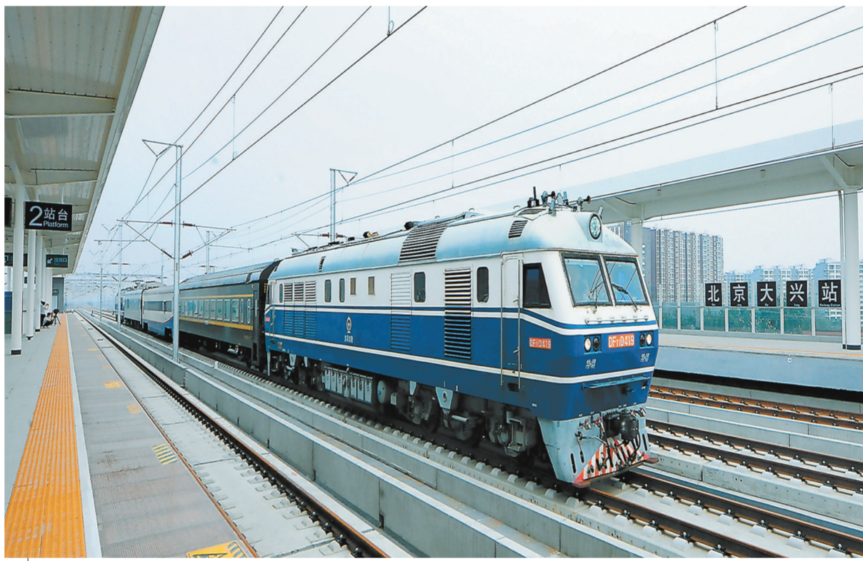
8月9日上午9时23分,一辆由北京西站始发的高铁检测机车通过京雄城际铁路大兴站向大兴机场站驶去,标志着京雄城际铁路北京段正式开始联调联试。按照规划,9月底,京雄城际铁路北京段将开通运营。届时,旅客搭乘高铁从北京西站到达大兴国际机场仅需20分钟。图为检测机车通过大兴站。 武羽摄
