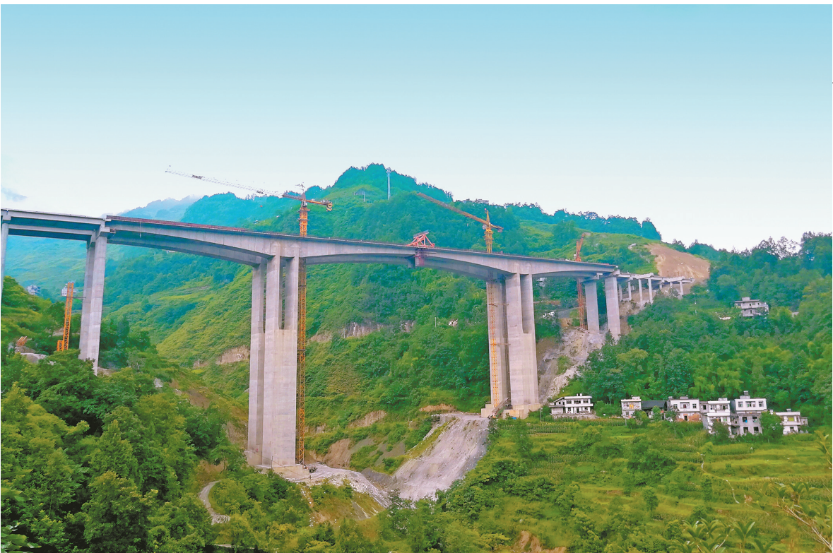
日前，由中铁二十局四公司承建的石黔高速公路首座连续刚构桥——连湖大桥主跨合龙。石黔高速公路全长83公里，建成后，黔江、石柱两地车程将由目前的3小时缩短至1小时。图为合龙后的石黔高速公路连湖大桥。
