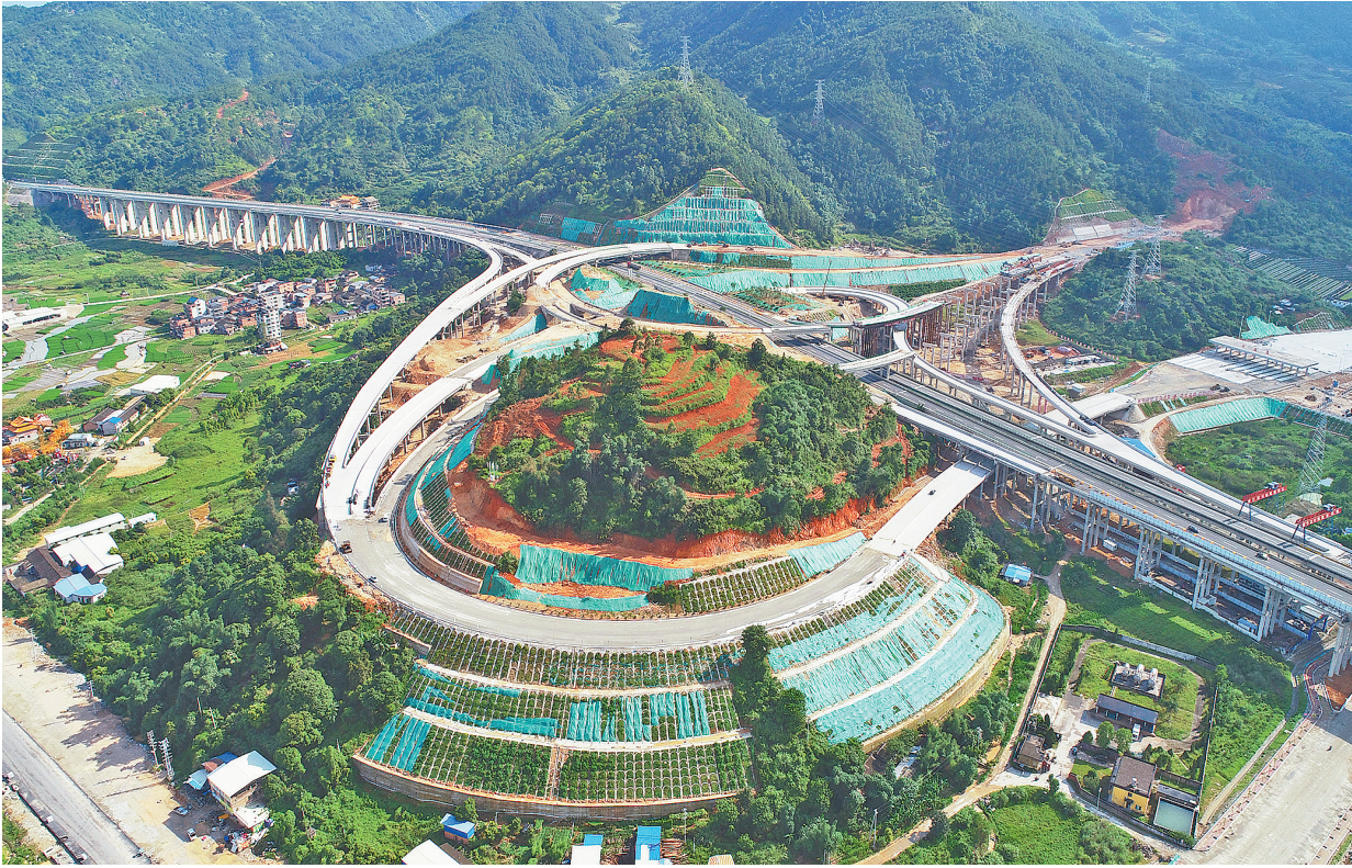
7月24日,由中铁十四局三公司承建的福建在建最大互通式立交桥——宁古高速公路六都互通式立交桥现浇梁全部浇筑完成,为顺利通车提供了保障。建设者采用BIM建模、智能检测张拉压浆系统和螺旋管贝雷梁支架等工艺工法,解决了国内罕见的小半径、大坡度、复合式曲线匝道桥梁建设难题。图为现浇梁浇筑完成的六都互通式立交桥。 林 琳 摄
