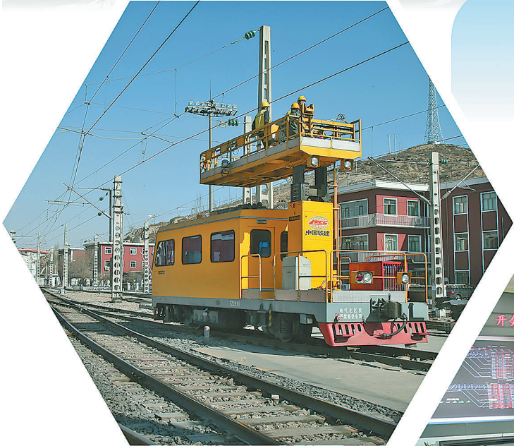
铁运公司包神铁路运营指挥部电务工区接触网检修。
