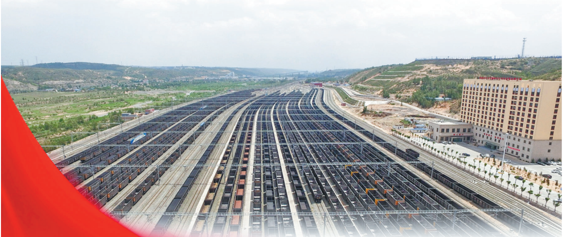
亚洲最大单场万吨货运编组站神朔铁路朱盖塔列检项目。
