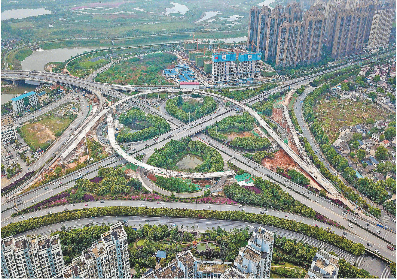
7月15日，由中铁二十五局三公司承建的长沙湘府西路罗家嘴立交桥改造工程主体完工。该项目毗邻洋湖湿地公园，项目部编制环水保专项方案，着力保护当地生态环境。图为湘府西路罗家嘴立交桥。 杨 宇 摄
