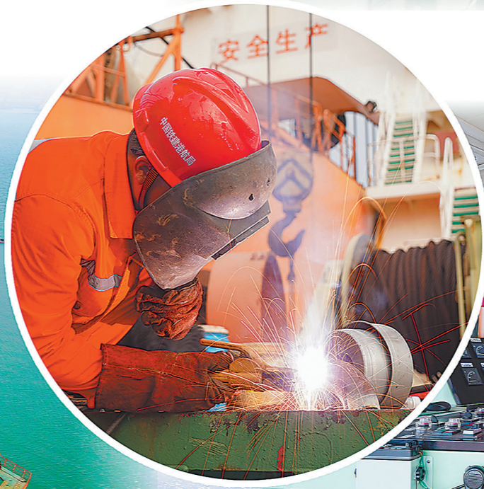
图为“铁建绞01”电焊工张斌正在进行焊接作业。 郭新璞 摄
