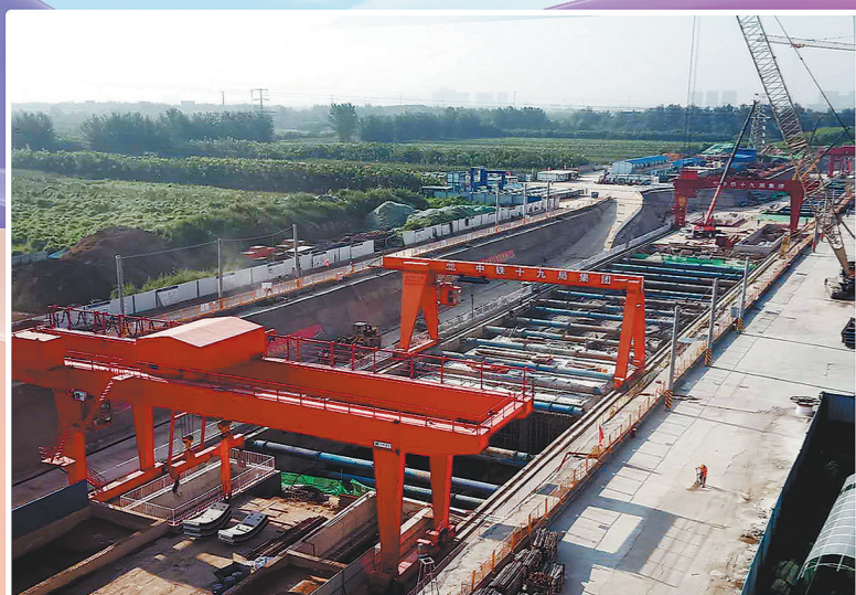
规范有序的施工现场
