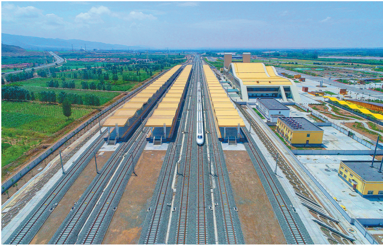
7月6日,综合检测车在中铁十六局等单位建设的宁夏吴忠至中卫城际铁路联调联试中跑出275公里的时速,达到设计时速的110%,圆满完成综合检测任务。图为综合检测车驶过中卫南站。丁俊逸 摄
