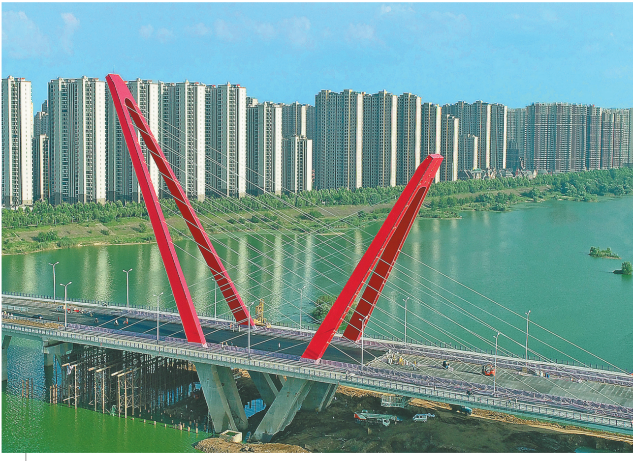
近日,中国铁建大桥局施工的安徽省六安市寿春路桥通车。该桥全长845米,其双向大倾角无背索斜塔斜拉桥结构为国内首创。图为造型独特的寿春路桥。李澎彬 摄
