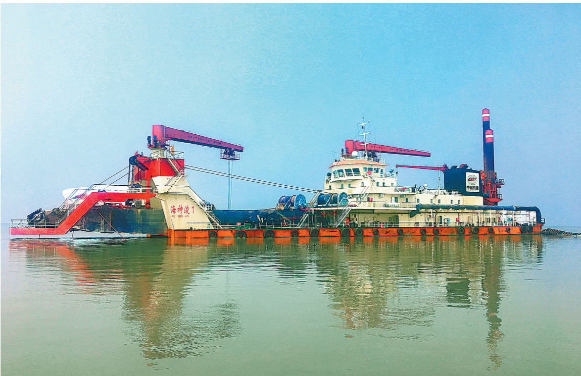
7月4日,中国铁建港航局总承包公司“海神凌1”绞吸船在孟加拉国帕德玛河右岸保护疏浚工程中1小时吹填方量突破3000立方米,打破了孟加拉国同类船舶的疏浚纪录。该工程是孟加拉国实行生态环境保护、水生态环境保护的重大民生工程,工程建成后有效缓解汛期河水对纳瑞阿区域右岸陆地的侵蚀。图为“海神凌1”正在孟加拉国帕德玛河上。
