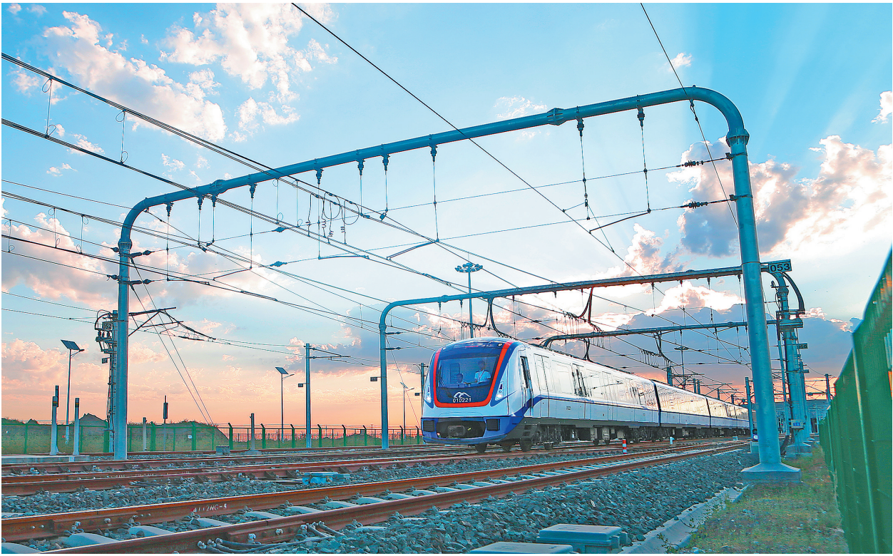
六月二十八日,由中国铁建参与设计建设的乌鲁木齐轨道交通一号线全线开通。该工程是新疆首条地铁,开通后将大大缓解乌鲁木齐市内交通压力。特别是在“一带一路”倡议的实施的下,该地铁的开通将对乌鲁木齐的对外开放和经济发展起到重要作用。图为地铁从百园路车站驶出。
